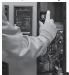
5. Führen Sie den Zuleitungsdrähten in den WiFi Anschluss der hauptsächlich Leiterplatine.
